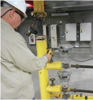
Medida de la temperatura del vapor a la entrada de la válvula del humidificador.
