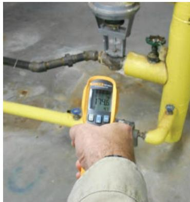
Vista de la temperatura de la línea de condensación desde un purgador para asegurarse de que funciona de forma adecuada.
