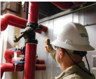
Medida de la temperatura del agua a la entrada del serpentín del climatizador.
